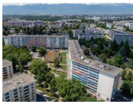
Les immeubles Camille-Martin et Sports de la SCHG © bureau Lacroix Chessex Architectes
